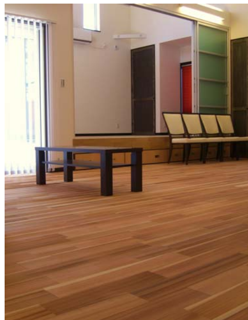
施工例 シーダークイーン#1011
